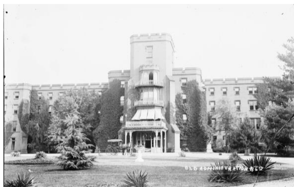
Fachada del Hospital.
