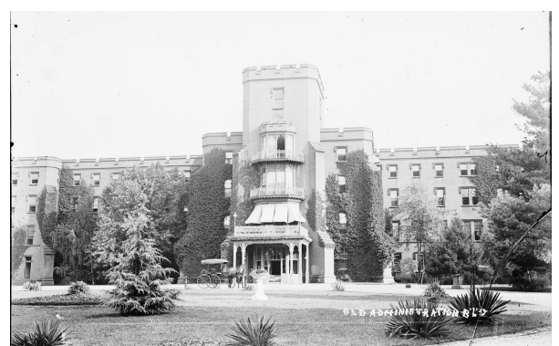
Fachada del Hospital.
