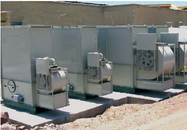
Torres de refrigeración
