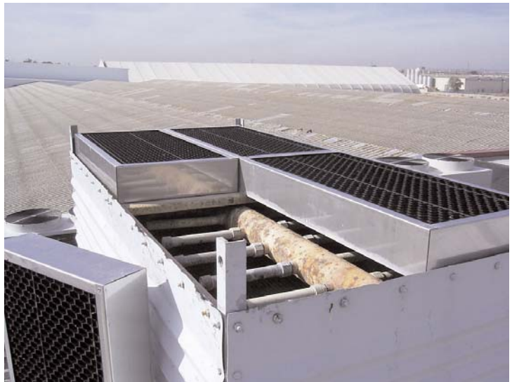
Separador de gotas de una torre de refrigeración
