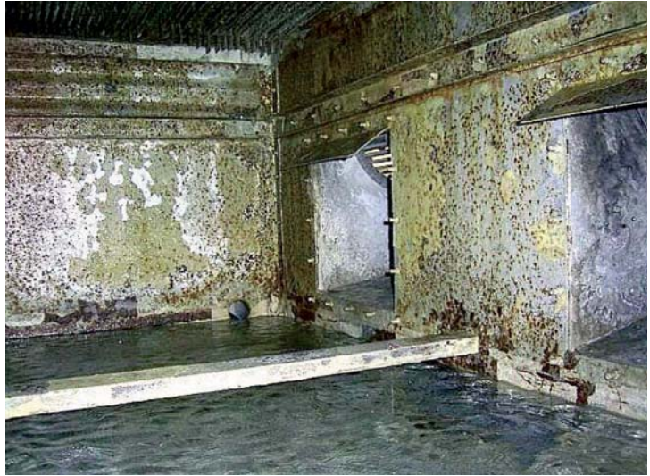
Corrosión por picadura: Interior de una torre de refrigeración.
