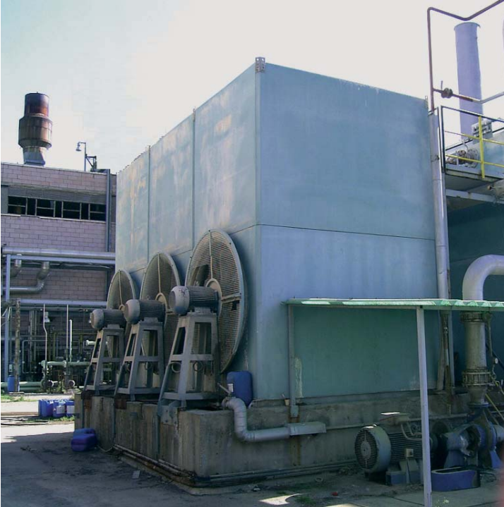
Torres de refrigeración de tiro forzado y ventilador axial
