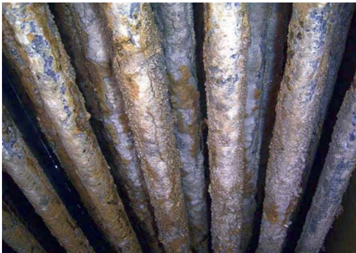
Depósito de incrustaciones en la batería de tubos de un condensador evaporativo.
