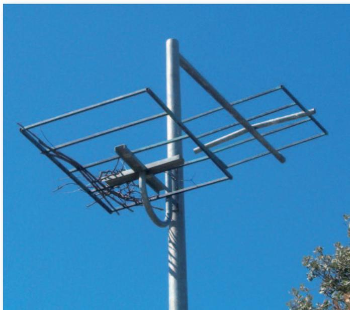
Protección frente a nidaciones de cigüeñas basada en la generación (plataformas) de lugares de nidación alternativa. Esta técnica permite preservar la seguridad de los ejados/cubiertas manteniendo nidos tradicionales.
